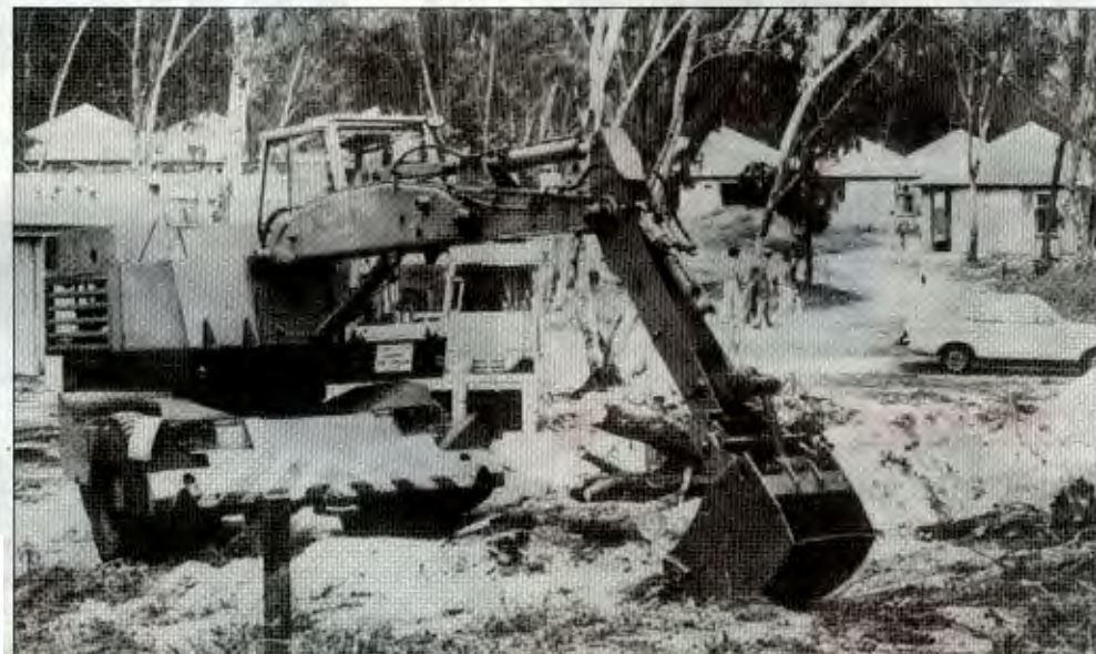
Les travaux de construction du VVF de Saint-Gilles en 1978.
